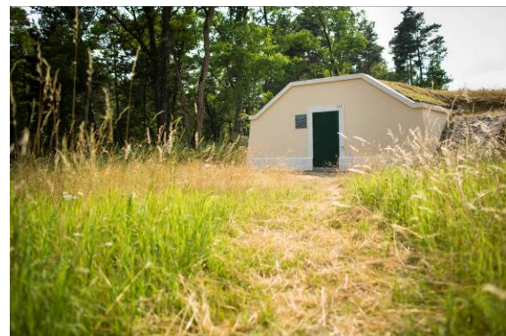
Regard sur l'aqueduc du Loing
