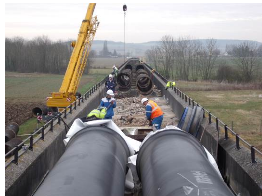
Remplacement de conduites, siphon de l'Yonne, aqueduc de la Vanne (77)
