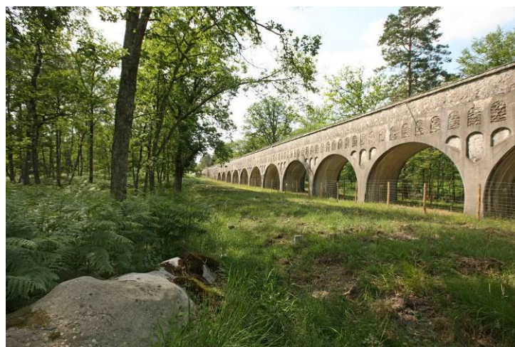
Aqueduc de la Vanne
