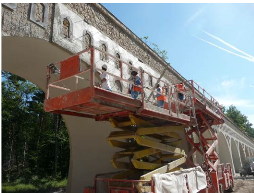
Rénovation des arcades du Grand Maître, aqueduc de la Vanne, forêt de Fontainebleau (77)
