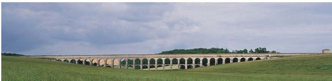
Aqueduc de la Vanne
