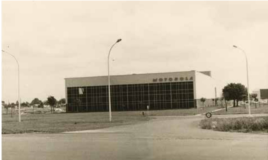
FAÇADE DE L'USINE MOTOROLA, 134 AVENUE DU GÉNÉRAL EISENHOWER, EN 1969
