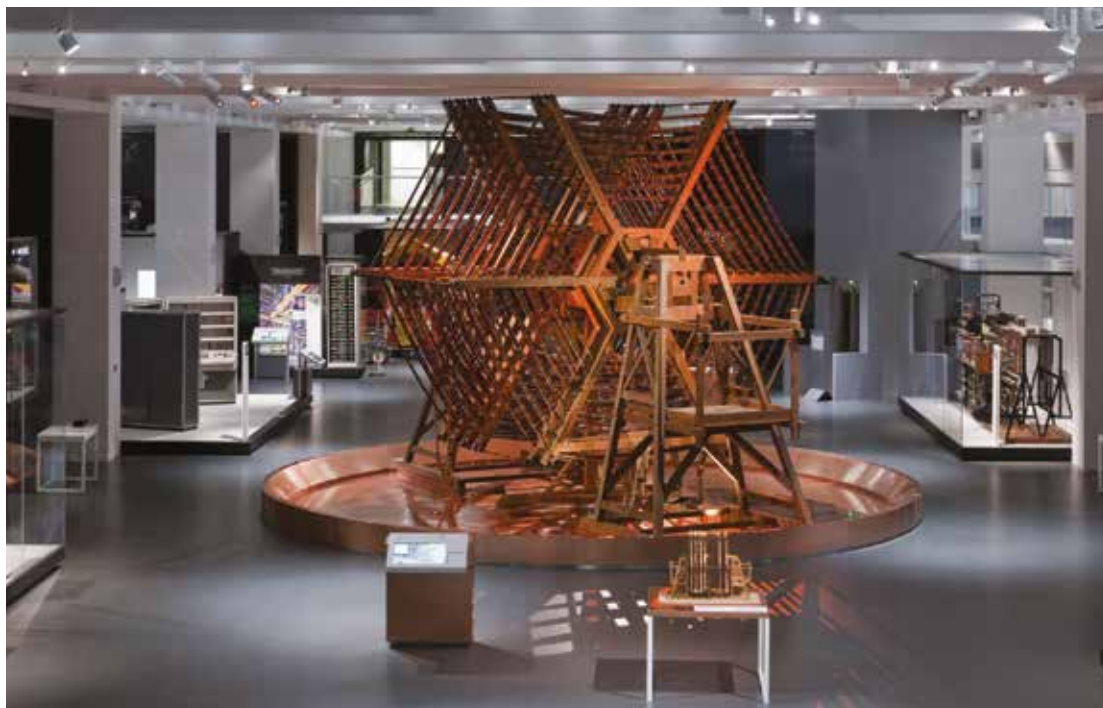
INDUCTEUR DE RÉGLAGE AÉRIEN DE L'ÉMETTEUR TRÈS BASSE FRÉQUENCE (16 KHZ) INSTALLÉ À LA STATION RADIO RUGBY, CONSTRUCTEUR INCONNU, BRITANNIQUE, 1943-1966 Science Museum / Science and Society Picture Library
